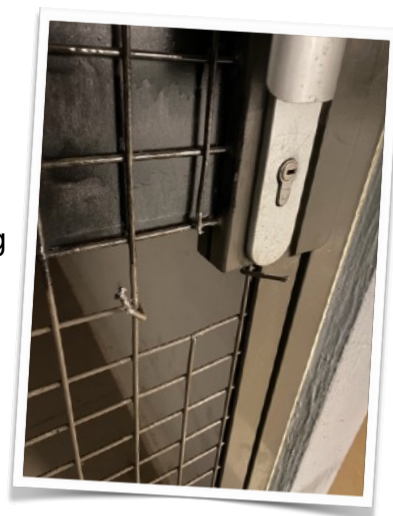
porte de local à vélos parking niveau -2
