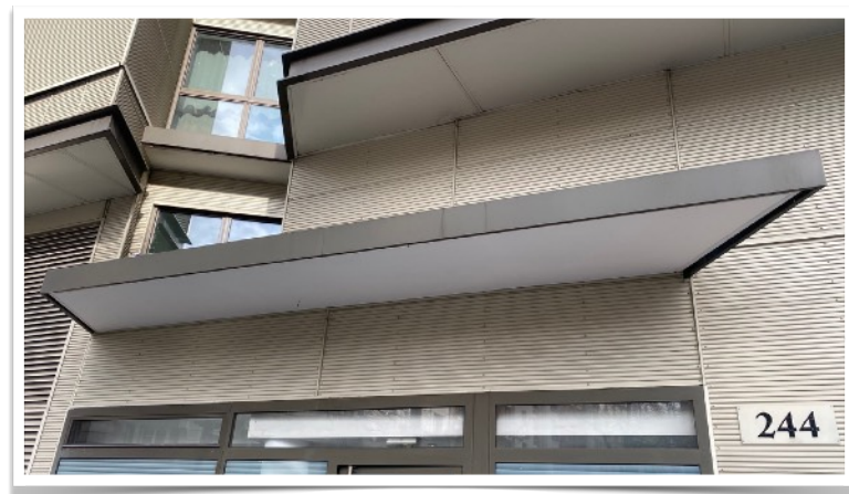
reprise de la sous-face de la casquette - Bâtiment F
